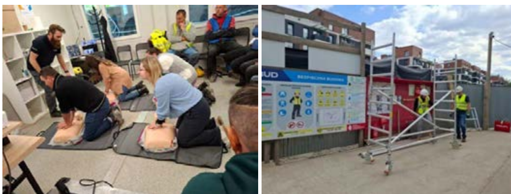
Budowa „Ceglana Park” - szkolenie z pierwszej pomocy oraz z montażu rusztowań
