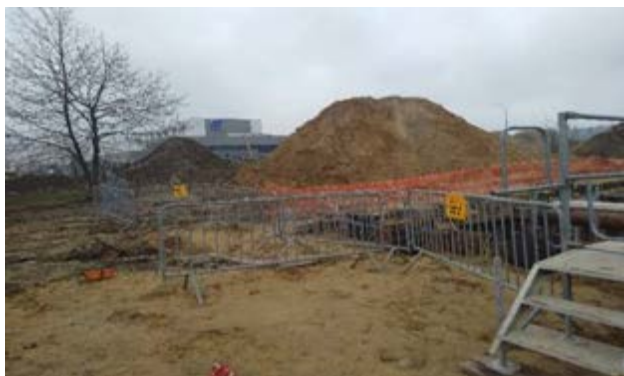
Wygradzenie wykopu.
