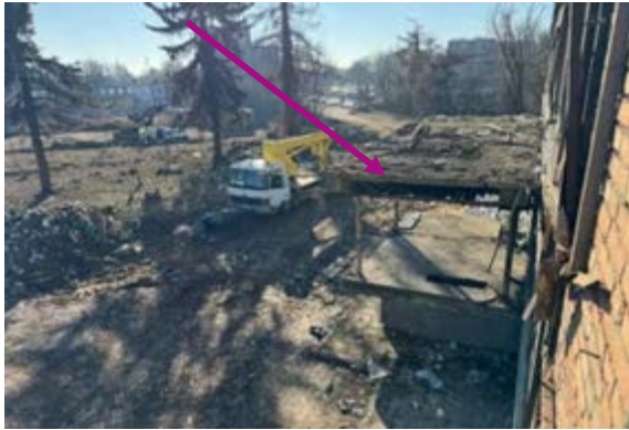
Brak zabezpieczenia przed rozprzestrzenianiem się i przenikaniem włókien azbestowych do gruntu
