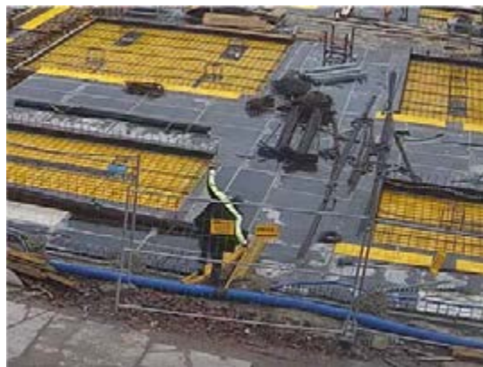
Prace związane z montażem deskowania stropu nad podziemnymi garażami. Montaż prowizorycznego pomostu roboczego z belek podporowych oraz moment, w którym doszło do upadku pracownika do wykopu na skutek przesunięcia jednej z belek.
