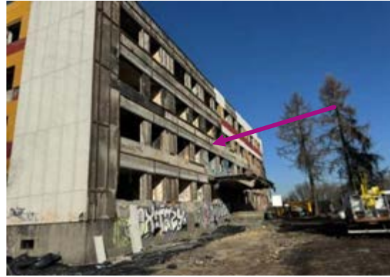
Brak zabezpieczenia przed rozprzestrzenianiem się i przenikaniem włókien azbestowych do gruntu
