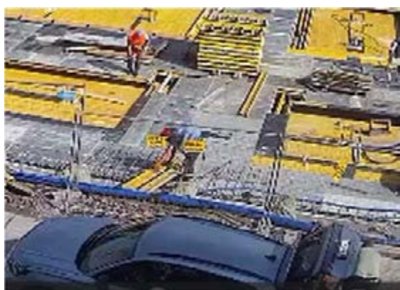
Prace związane z montażem deskowania stropu nad podziemnymi garażami. Montaż prowizorycznego pomostu roboczego z belek podporowych oraz moment, w którym doszło do upadku pracownika do wykopu na skutek przesunięcia jednej z belek.
