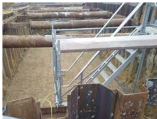
Zapewnienie bezpiecznego zejścia do wykopu schodnią systemową
